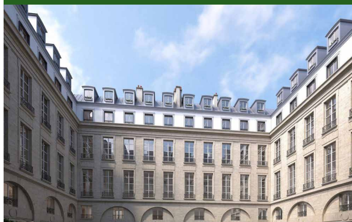
Figure 30 : Rénovation Carré Concorde – BBC Effinergie Rénovation – Architecte : CALQ Architecture – MO : Dentressangle– Paris (75)
