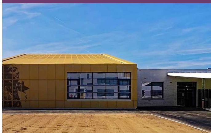
Restauration - Collège St Exupéry - Observatoire BBC
